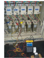
VSK拥有国际先进的谐波测试设备，可为用户现场精确测量谐波份量，并可提供详细的数据报表。
